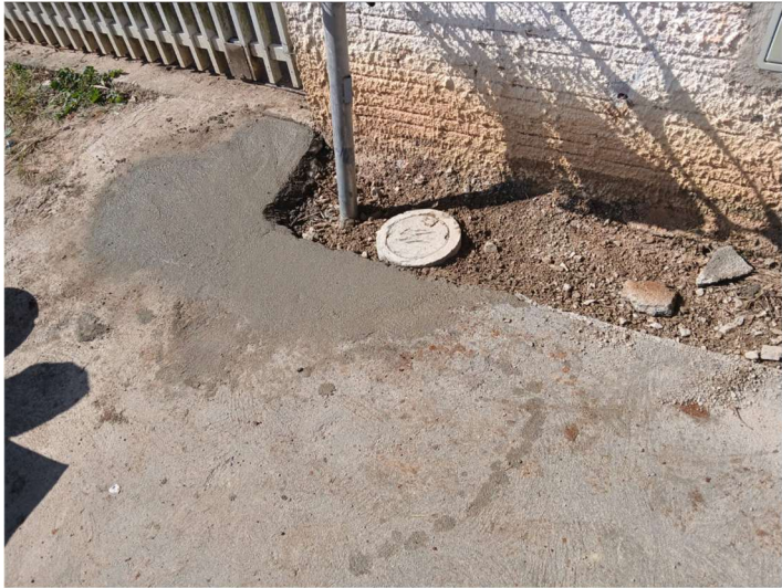
Após recuperação de calçadas
