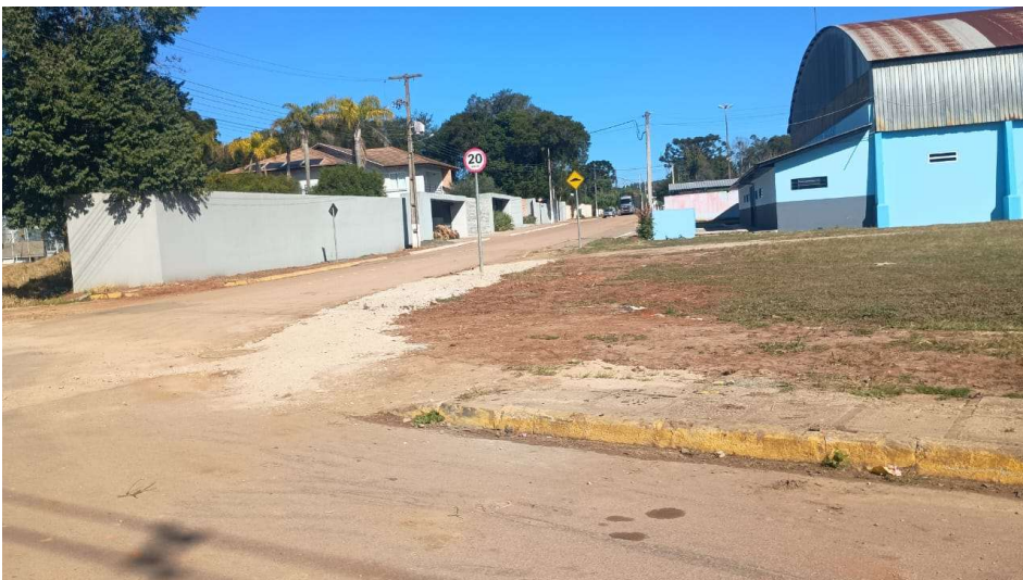
Após recuperação de via urbana
