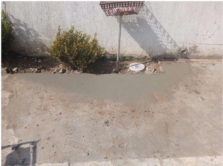
Após recuperação de calçadas
