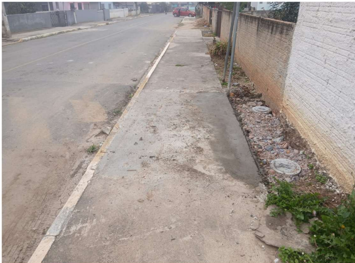
Após recuperação de calçadas
